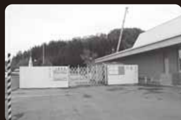
建設中の京極町給食センター
